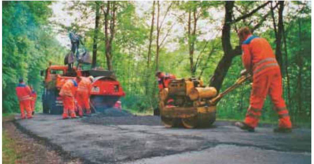
Kurzer Prozess: Einbauen, abwalzen – fertig ist die Tragschicht für die reparierte Schwarzdecke. (Fotos: Bagela)
